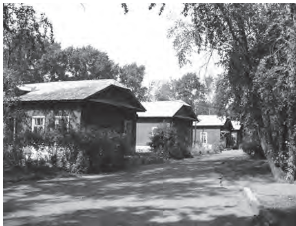
Здание Котласской больницы, где оперировал свт. Лука
